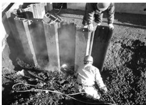
写真－3 鋼矢板切断状況（頂部の処理）
