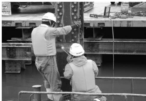
写真－2 H鋼杭切断状況
