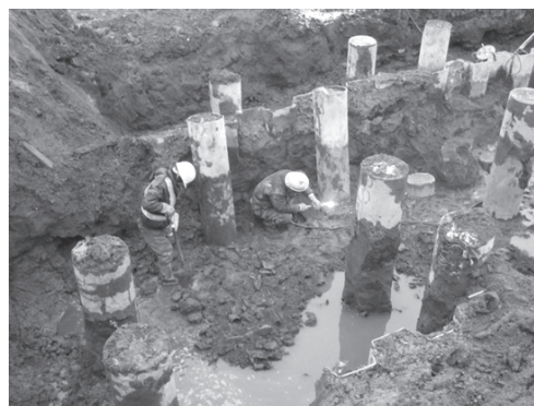
写真-1 鋼管杭切断状況（杭頭処理）
