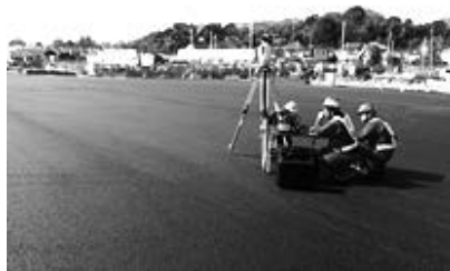
写真-9 TLSによるアスファルト舗装の出来形測定
