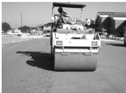
写真－6 \alpha システムによる転圧状況
