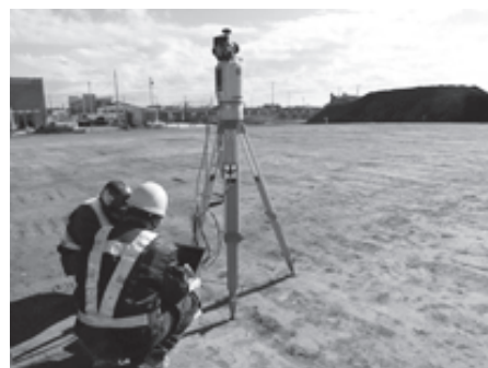
写真－４ TLS による路床盛土工の出来形測定状況
