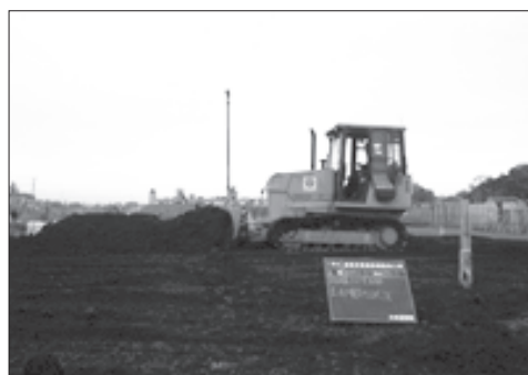
写真－３ MC ブルドーザによる路床盛土施工状況
