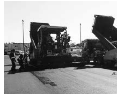
写真－8 MCAs/F による施工状況
