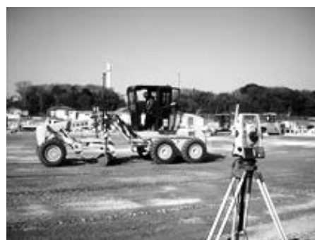
写真－5 MCMG による敷きならし状況
