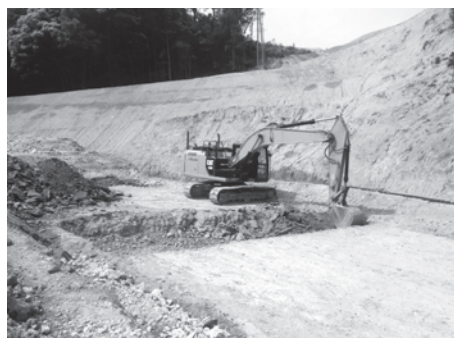
写真－7 丁張レスによる枕工部の掘削状況
