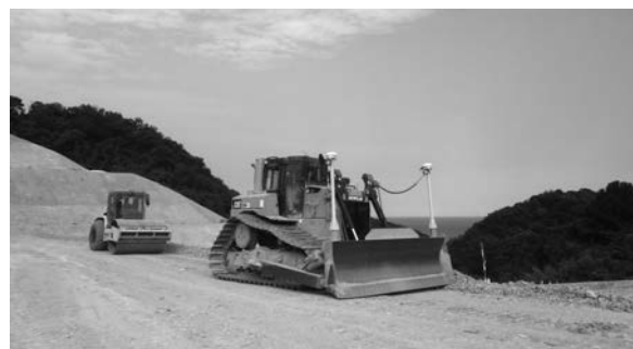
写真-2 マシンコントロールブルドーザー (奥に見えるのは振動ローラー)
