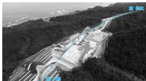
写真－1 施工状況
