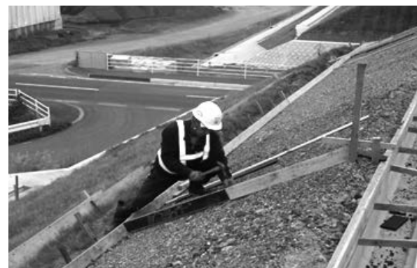
写真-2 目地材設置
