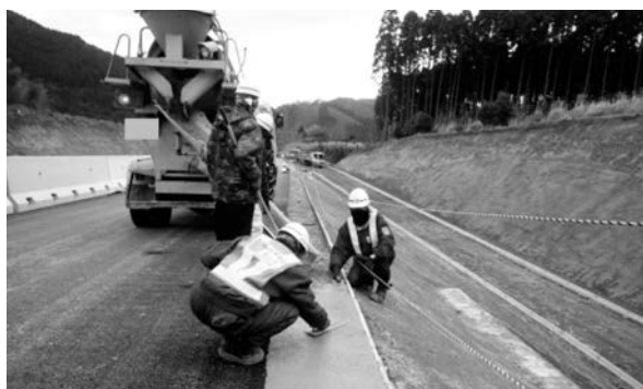
写真-4 コンクリート打設(人力)・表面仕上
