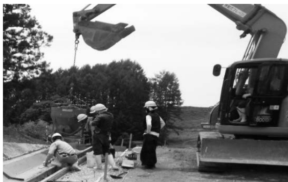
写真-3 コンクリート打設 (クレーン機能付きバックホウ)
