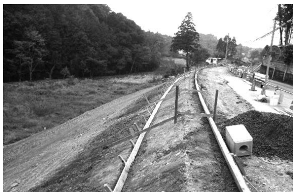
写真-1 型枠工 (組立)
