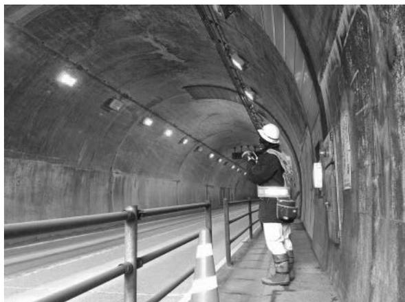
写真－1 トンネル緊急点検
