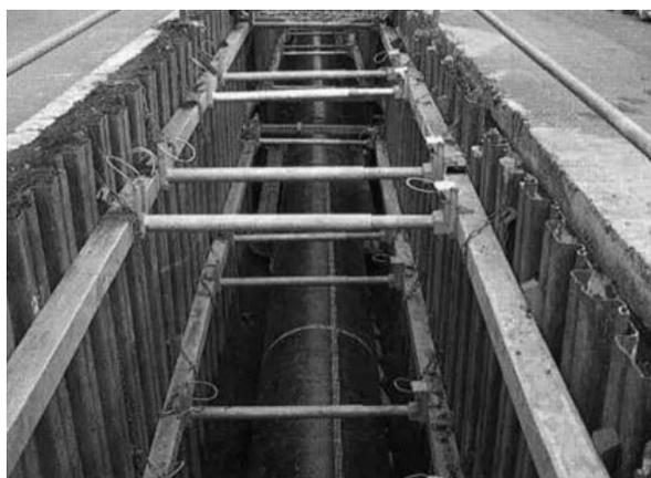
写真-3 軽量鋼矢板土留工の設置状況
