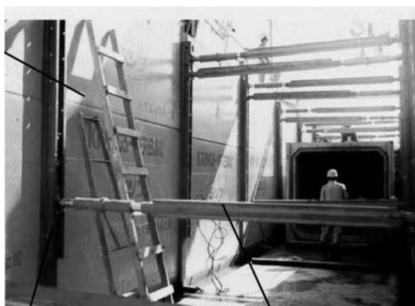
写真-4 たて込み簡易土留の設置状況
