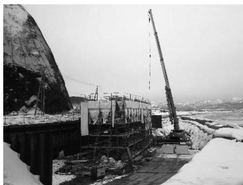
写真-6 雪寒仮囲い設置状況（W・PWタイプ）
