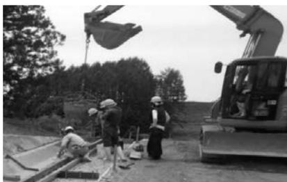
写真-1 防草コンクリート（バックホウ）打設状況
