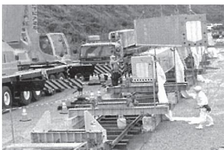
写真-12 PC 中空床版桁主桁組立状況
