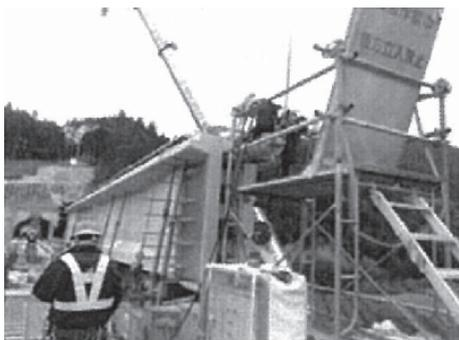
写真-11 PC コンボ桁主桁組立状況
