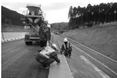
写真-2 防草コンクリート（人力）打設状況
