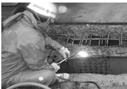
写真-4 鋼材現場ガス切断状況
