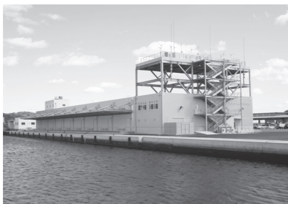
写真－２ 津波避難機能を備えた漁業施設 （串本町 串本漁港）
