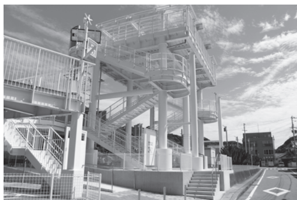
写真－５ 津波避難タワー（すさみ町）
