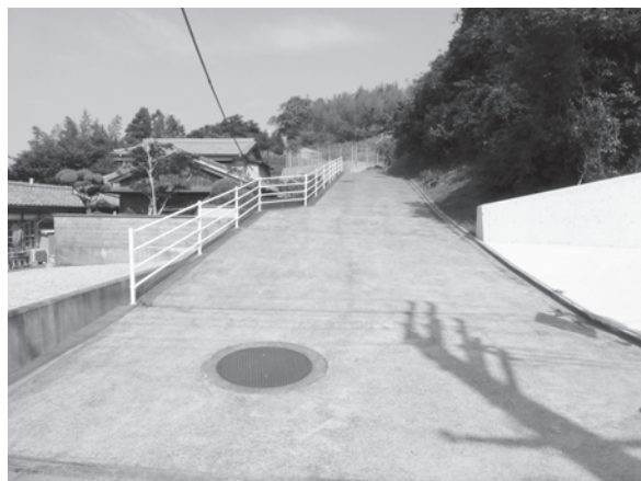
写真－３ 地域による津波避難路の整備 （田辺市橋谷地区 避難広場への避難路）
