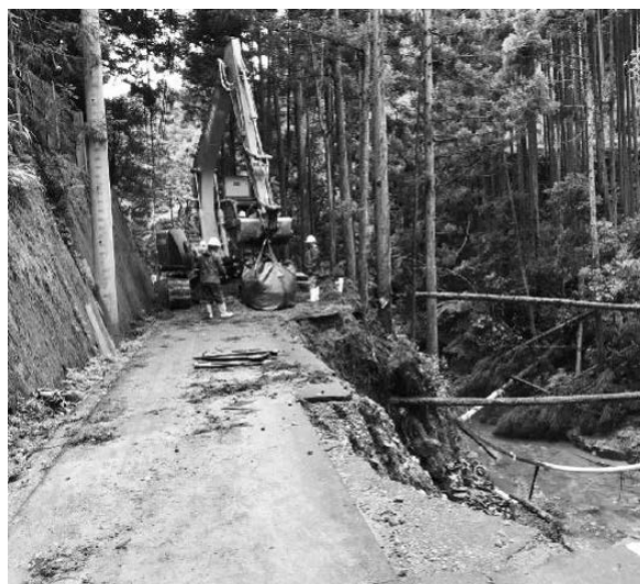
写真－5 孤立解消のため県道日田宝珠山線応急工事
