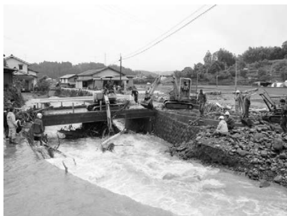
写真－6 河川の橋梁部を閉塞する流木撤去作業
