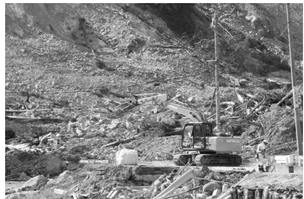
写真－2 斜面崩壊現場で道路応急復旧工事を行う会員企業
