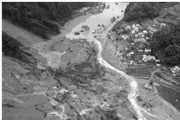
写真－1 日田市小野地区：山の斜面が崩壊し土砂ダムが発生
