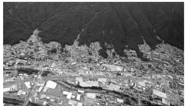
写真-1 安佐南区八木・緑井地区の被災状況 （平成 26 年 8 月 20 日 国土地理院撮影）
