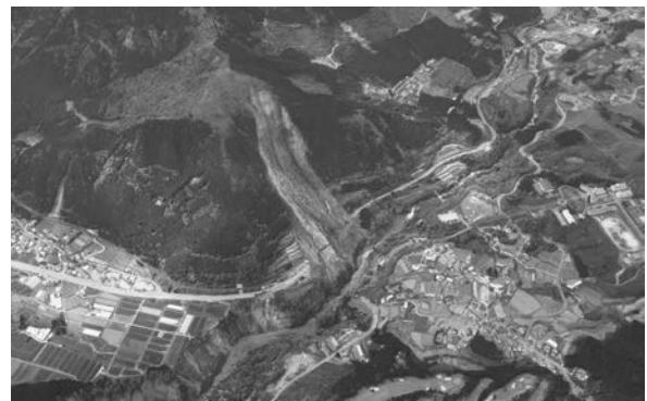
写真－1 大規模な斜面崩壊により寸断された 国道 57 号（阿蘇大橋付近）
