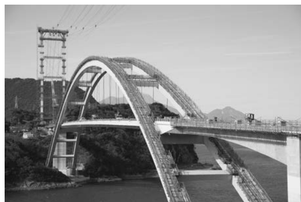
写真－5 大矢野バイパスで整備中の新たな橋
