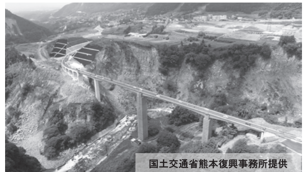
写真－3 開通した阿蘇長陽大橋
