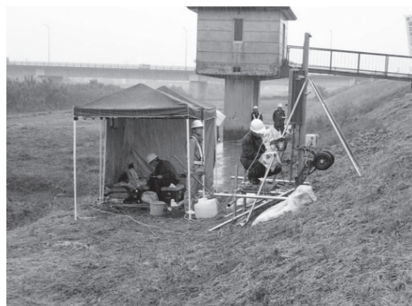
写真-5 ピエゾドライブコーンの実現場による検証状況
