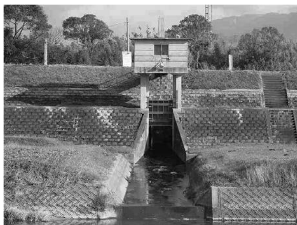
写真－1 樋管（河川構造物）
