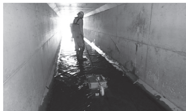
写真－3 鉄筋コンクリート対応型空洞調査用 GPR システムの実現場による検証状況
