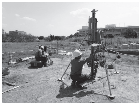
写真-4 ピエゾドライブコーンの供試体による検証状況
