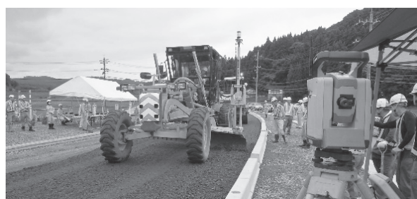
写真－4 ICT モーターグレーダーによる路盤工
