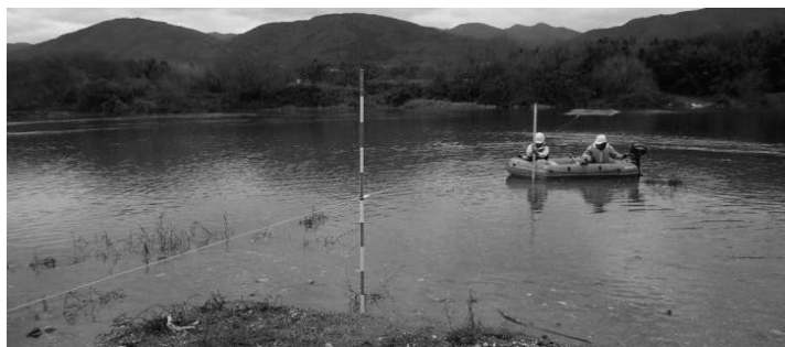
写真-2 手作業による深淺測量の様子
