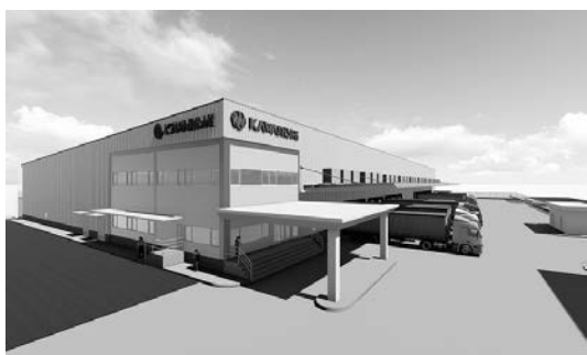
写真－5 冷凍冷蔵倉庫
