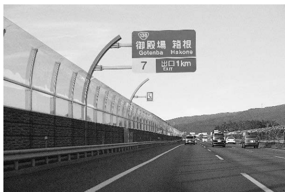
写真-6 他の道路附属物等を一体的にデザインした事例
