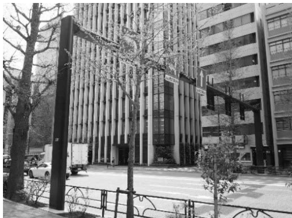
写真-4 断面寸法を道路縦断方向で確保し 景観阻害を軽減
