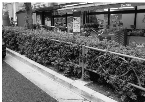
写真－１ 植樹帯と防護柵の併設（防護柵は不要）
