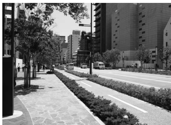
写真－7 歩道と自転車道が併設されている場合の視覚的な変化に配慮した事例
