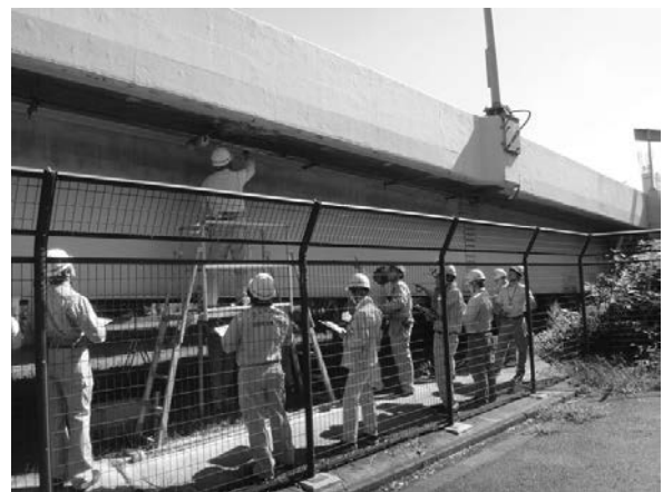
写真－5 研修の状況（上：講義、下：点検実習）
