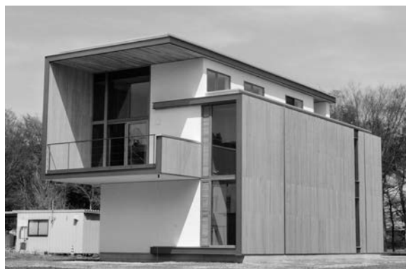
写真－1 CLTパネル工法実験棟
