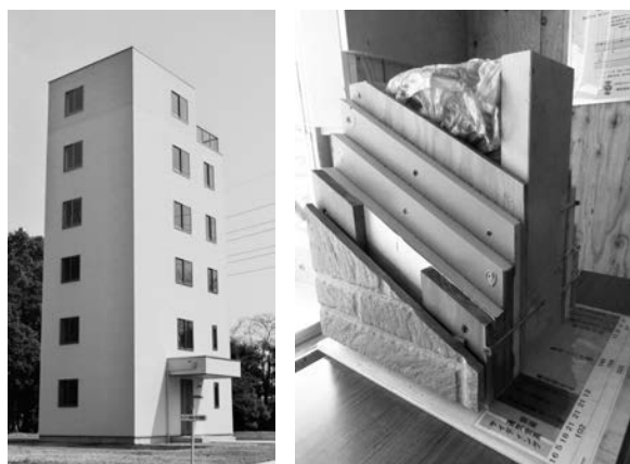
写真－2 6階建て枠組壁工法実験棟 （左：外観，右：2時間耐火構造の外壁）
