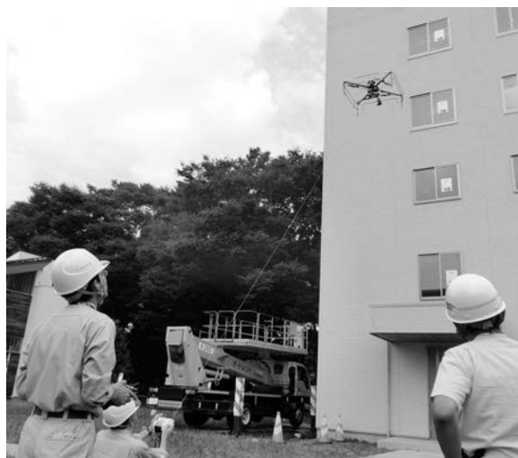
写真-3 UAV を活用した点検・維持管理手法検証実験 (写真は、平成 29 年 8 月に実施した実験の様子)
