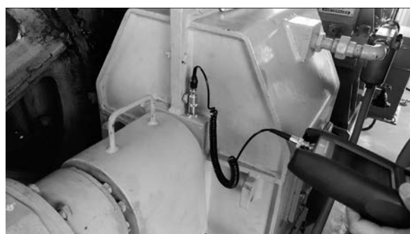
写真－1 河川用ゲート設備診断実施状況 （振動計測）
