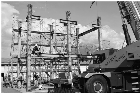
写真－２ 建築多能工基礎コースの実習
