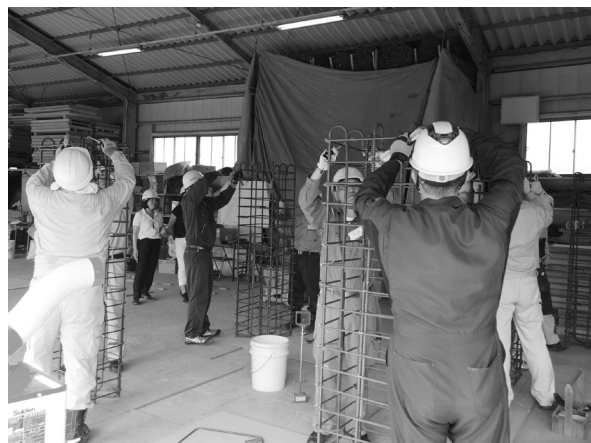
写真－4 工業高校の教師も鉄筋組立や型枠施工を学ぶ
