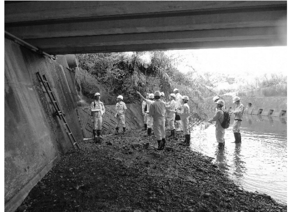
現地実習の状況
