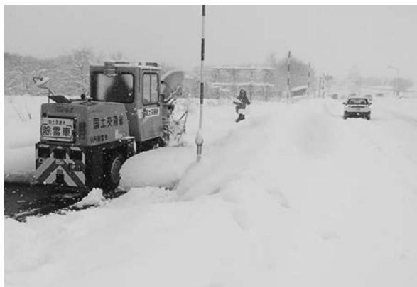
写真－5 歩道除雪作業状況
