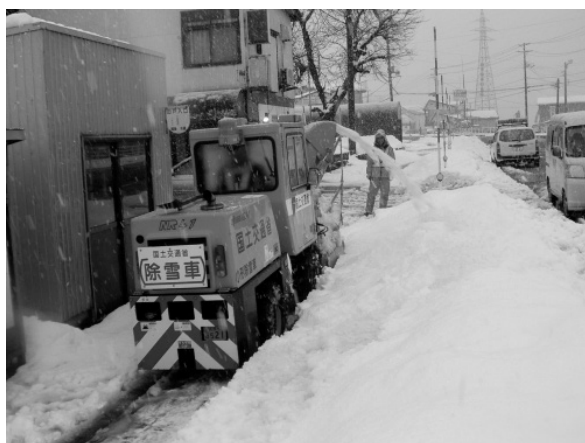
写真－2 歩道除雪作業状況
