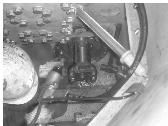
写真－2 リレービットの交換状況
