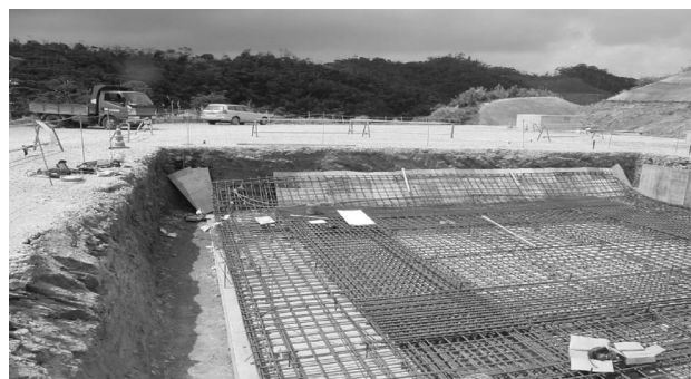
写真 1 事故現場(鉄筋の倒れた状況)
