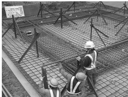
写真 3 鉄筋架台設置状況
