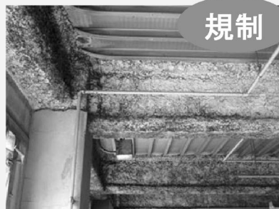
アスベスト含有吹付けロックウール
