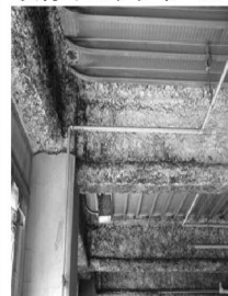
アスベスト含有 吹付けロックウール
