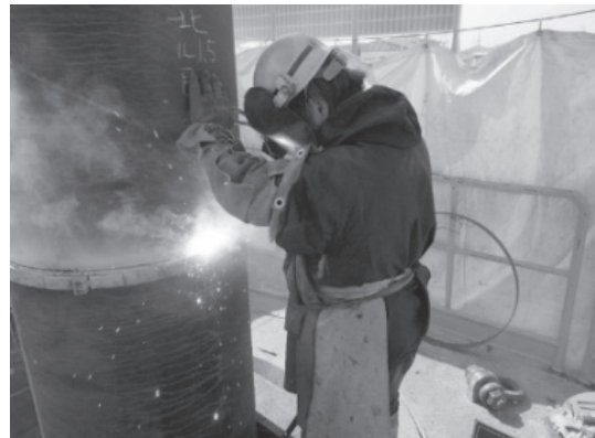
写真－５ 作業状況（継杭溶接）
