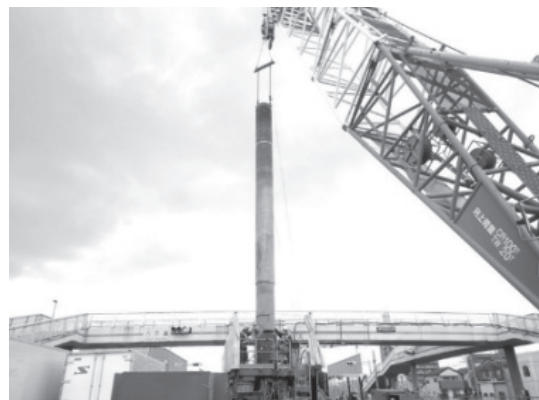
写真－６ 作業状況（ヤットコ建込）
