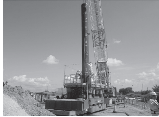
写真－４ 作業状況（回転貫入）
