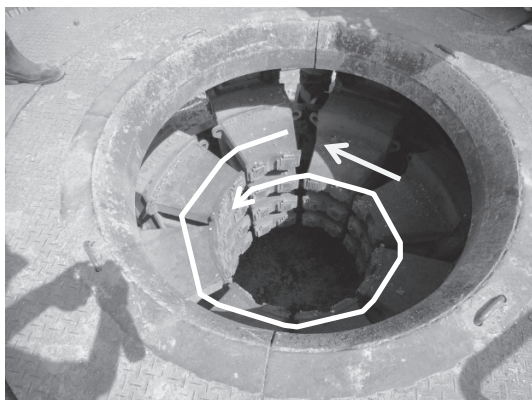
写真－２ 杭回転用カラー（開口タイプ）
