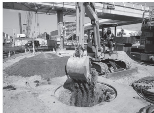
写真－７ 作業状況（穴埋・整地作業）
