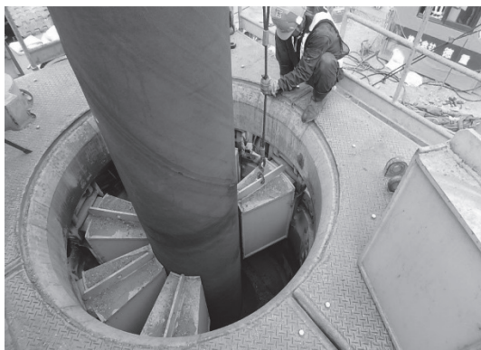
写真－３ 杭回転用カラー（開端タイプ）
