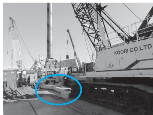
写真－9 回転反力装置
