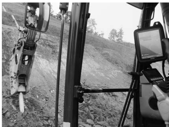
写真-8 モニターとブレーカーによる施工
