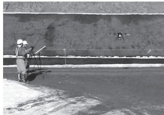
写真－3 UAVによる測量実施状況
