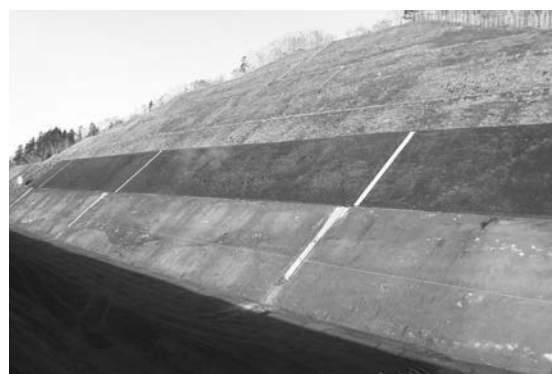
写真-9 中硬岩・硬岩の法面整形完了後
