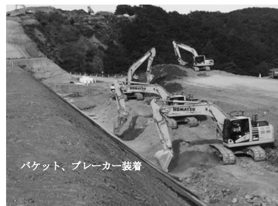
写真-6 法面整形状況1 (丁張り無し)
