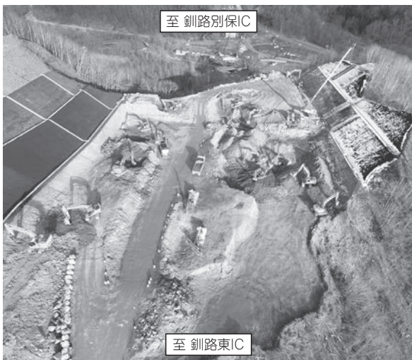
写真－2 施工状況
