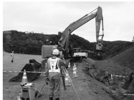
写真-5 アタッチメントの座標点検実施状況
