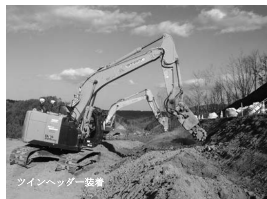
写真-7 法面整形状況2 (丁張り無し)
