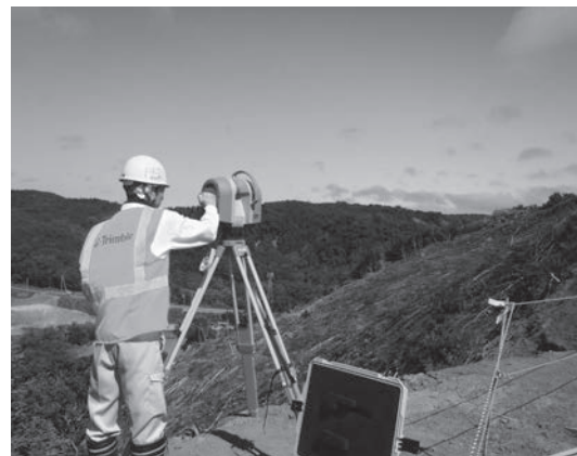
写真－4 LSによる測量実施状況
