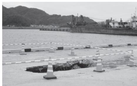
図-3 港湾における損傷事例
