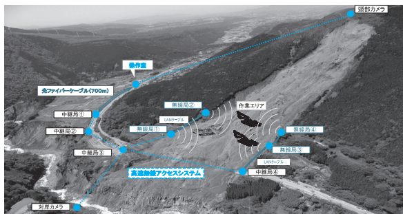
写真-3 阿蘇大橋地区の無人化施工
