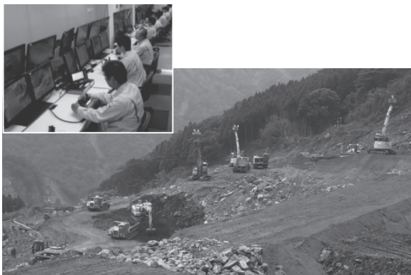
写真-4 無人化施工の状況
