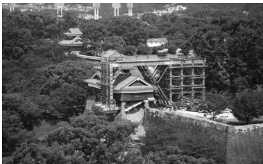
写真－6 飯田丸五階櫓の倒壊防止工事
