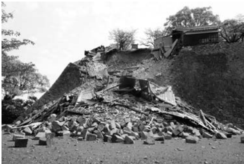
写真－4 重要文化財建造物の被害（北十八間櫓）
