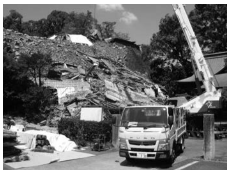
写真－7 崩壊した東十八間櫓・石垣の撤去工事
