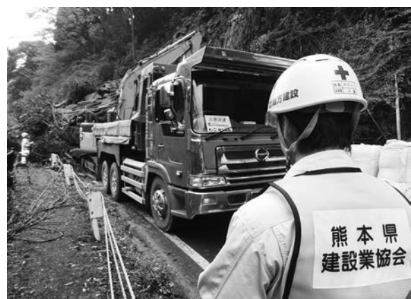
写真-2 道路啓開：道を塞ぐ土砂撤去
