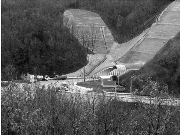
写真-5 復旧を終えた俵山ルート
