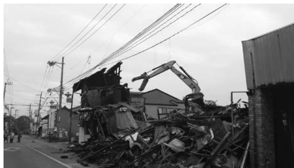
写真－4 道路啓開：道を塞ぐ倒壊家屋撤去
