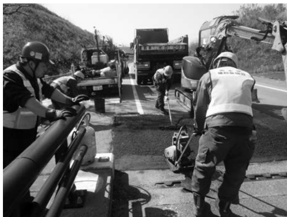
写真－3 道路補修：段差解消
