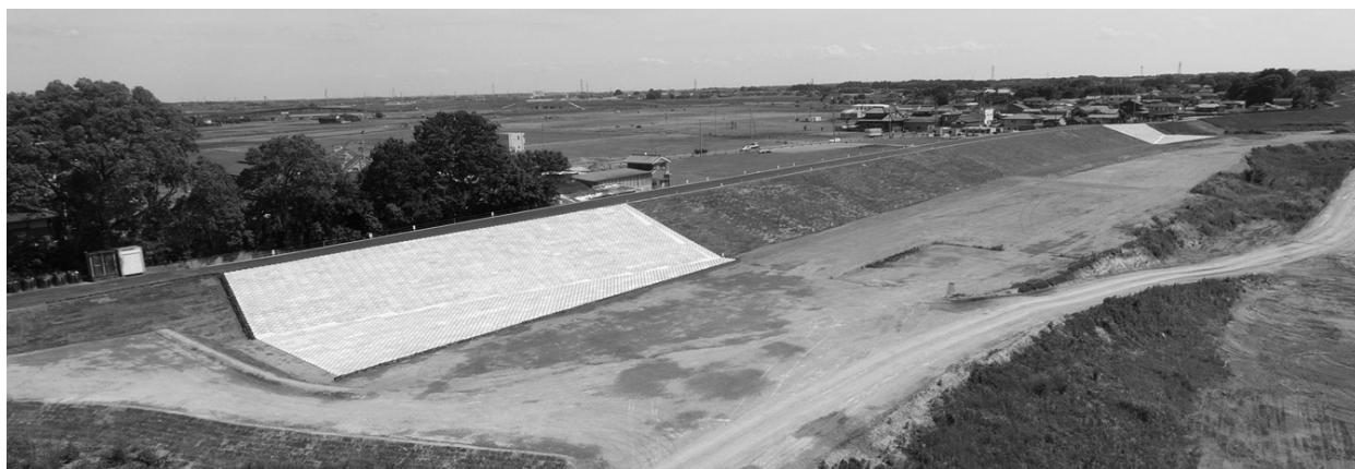
写真－5 三坂地区堤防完成（平成 28 年 6 月 10 日撮影）
