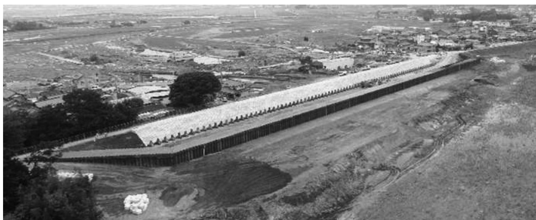
写真-1 緊急復旧完了
