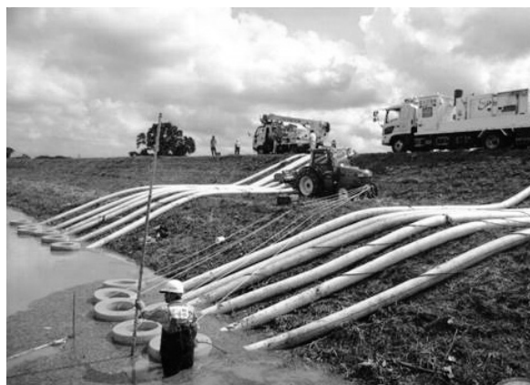
写真－2 TEC-FORCE による排水ポンプ車排水状況
