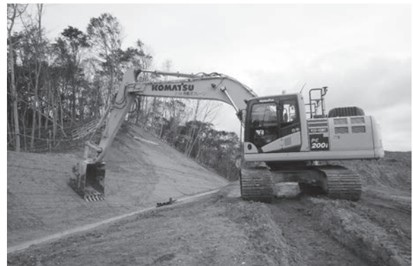
写真-4 ICTバックホウ法面整形状況
