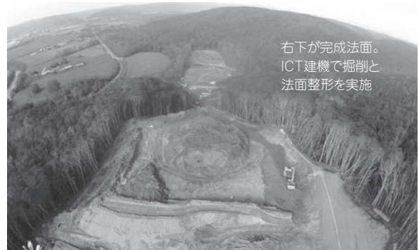
写真-3 ICT土工施工中
