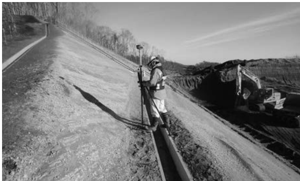
写真-6 GNSSローバーによる出来形確認
