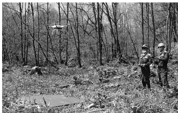
写真-1 UAV（ドローン）による施工前の測量
