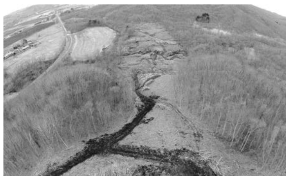
写真-2 着工前（奥が起点側）
