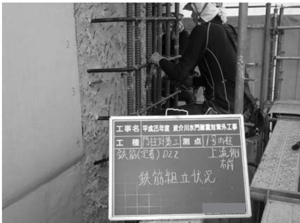
写真-5 鉄筋組立状況
