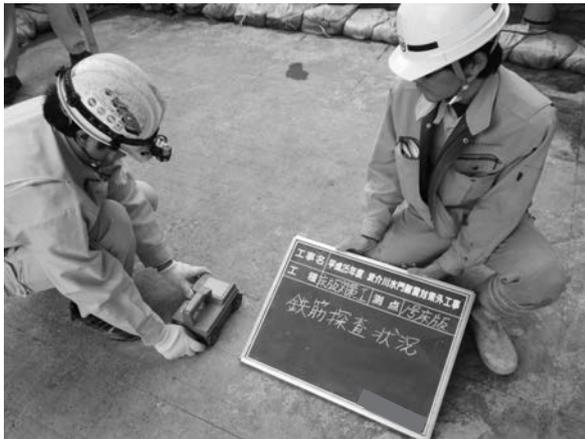
写真-1 鉄筋探査状況
