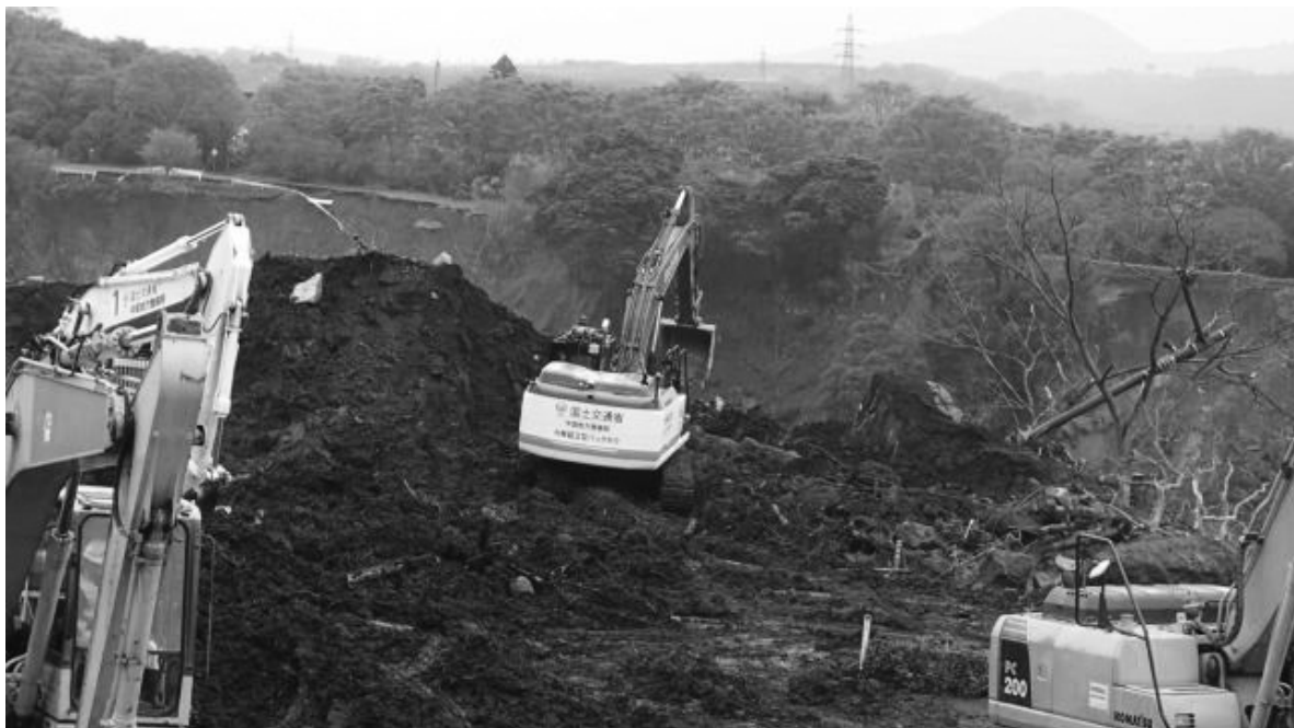
写真—12 稼働状況（H28.4.24 阿蘇大橋付近土砂撤去）
