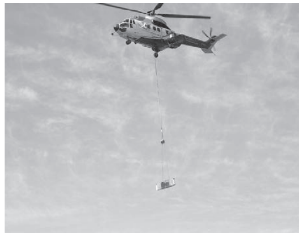
写真—8 ウェイト上部の空輸状況
