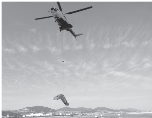
写真—7 ブームの空輸状況
