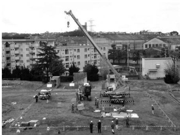
写真ー2 ラフテレーンクレーン（25t）による分解状況
