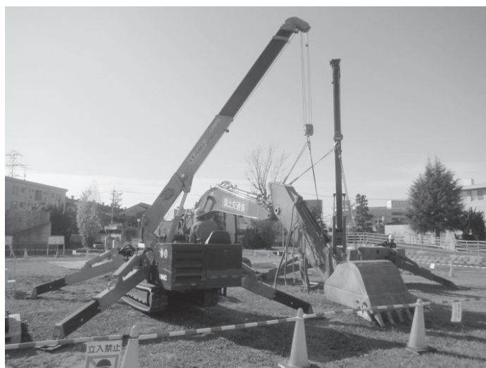
写真一15 小型式クローラクレーン
