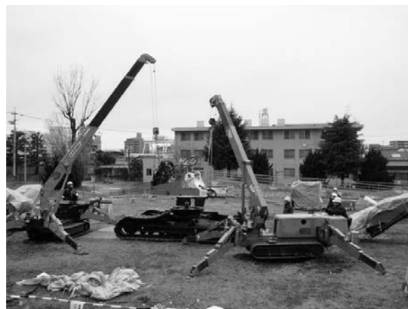
写真ー3 小型式クローラクレーン（2.9t吊り）による組立状況
