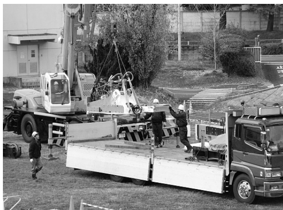
写真一 5 ラフタークレーン（25t）による積込状況
