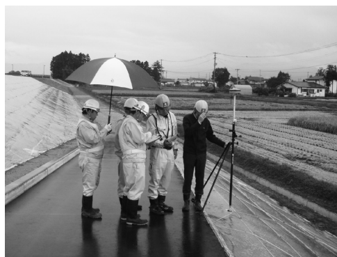
写真—5 実地検査の様子
