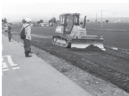
写真—1 ICT建機による盛土（敷均し）
