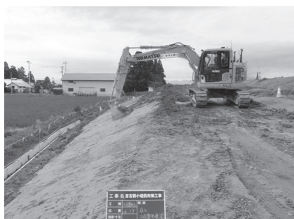
写真—2 ICT建機による法面整形
