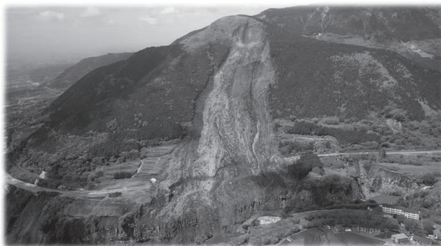
4月16日の本震により長さ約700m、幅200mの大規模崩落が発生。主要幹線道路である国道57号や阿蘇大橋を含む国道325号が被災。
