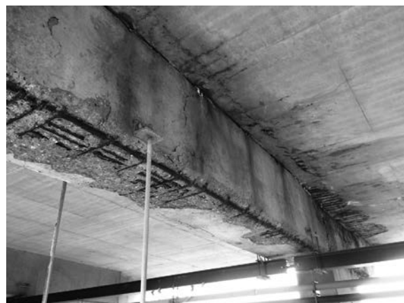
(2) 柱頭部および床版
