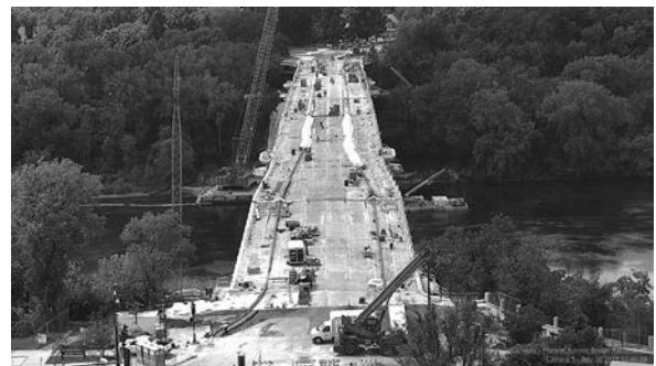
(3) 7月30日【床版完了, 防護柵・高欄施工中】
