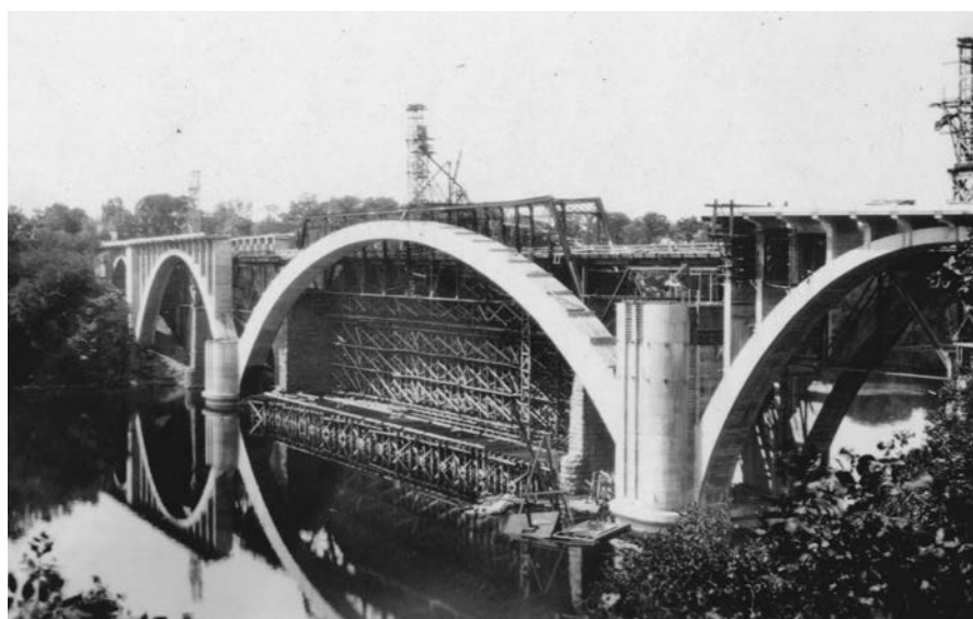
写真－1 Franklin Avenue Bridge建設中の様子（1919年） （出典：Hennepin County Library）
