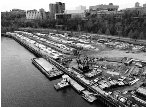
(1) 製作ヤード全景
