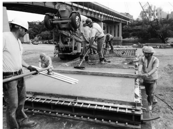
(2) コンクリート打設
