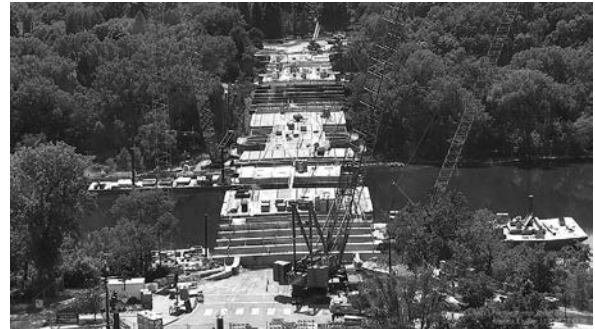
(2) 6月11日【床版/柱頭部一撤去・架替最盛期】
