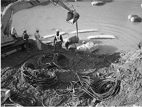
写真 6 芋川河道閉塞での排水ポンプ設置
