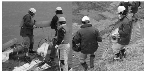
写真 11 新型排水ポンプの据付作業状況
