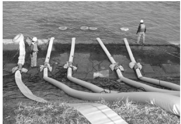
写真 7 タンデム接続による排水作業
