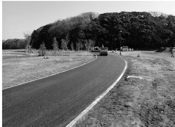
写真一1 公共公園整備（総合）工事
