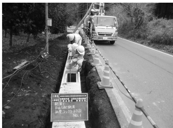
写真一3 県単排水整備工事及び県単舗装道路修繕合併工事
