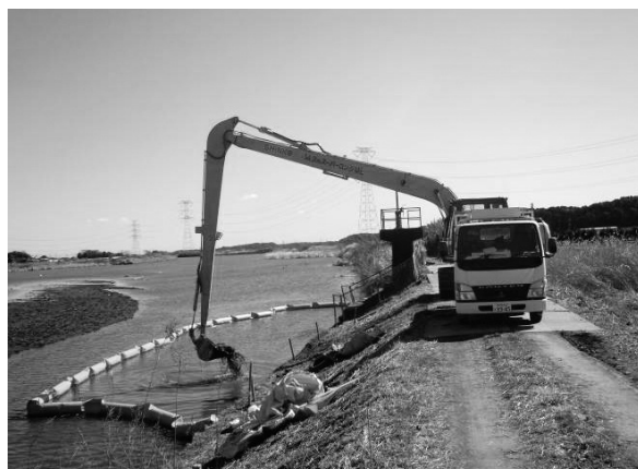
写真一2 県単河川維持工事
