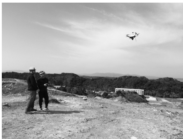
写真—1 ドローンによる3次元測量
