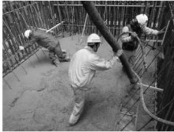
充填不良を防止するための振動締め作業
