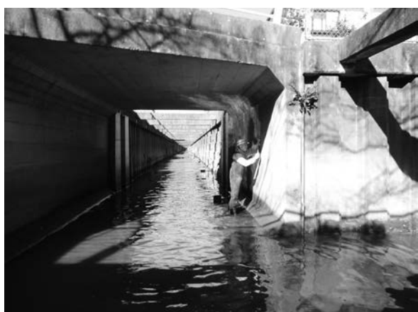
写真一 2 定期点検 （橋長 2 m以上15m未満（Type2））
