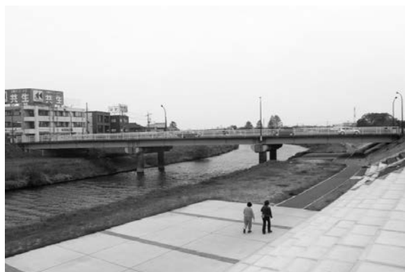
写真—4 新平和橋全景
