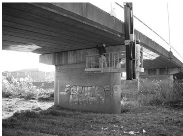
写真一 1 定期点検（橋長15m以上（Type1））
