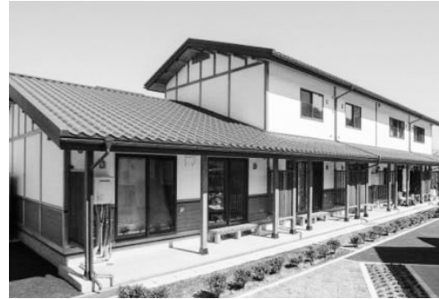
写真三 災害公営住宅 (岩手県大槌町大ケ口地区)
