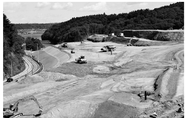
写真四 高台造成 (宮城県東松島市野蒜北部丘陵地区) 出典: UR
