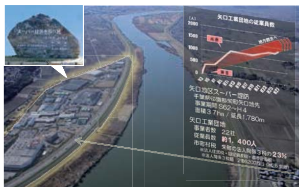
写真—5 スーパー堤防上に進出した矢口工業団地
