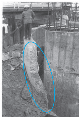
建設時(止水壁撤去状況)
