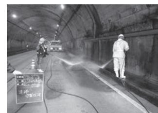
(トンネルの清掃)
