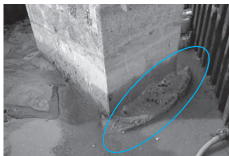
補修・補強工事(止水壁の一部)
