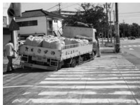
写真一 2 管路の老朽化に起因する道路陥没
