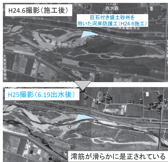
写真一4 施工後～出水後の河道の変遷 (常願寺川右岸11.7k施工箇所)
