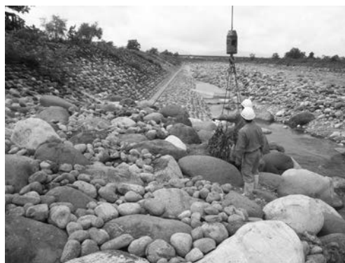
写真—7 リップラップ工の補修状況
