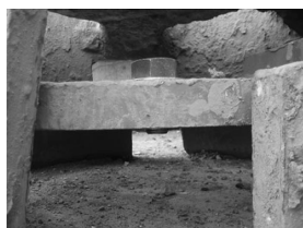
写真—6, 7 ボルト取付け部
