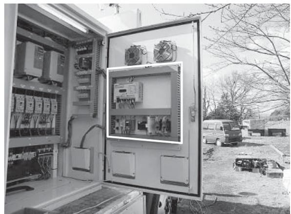
写真—3 車載装置取付状況
